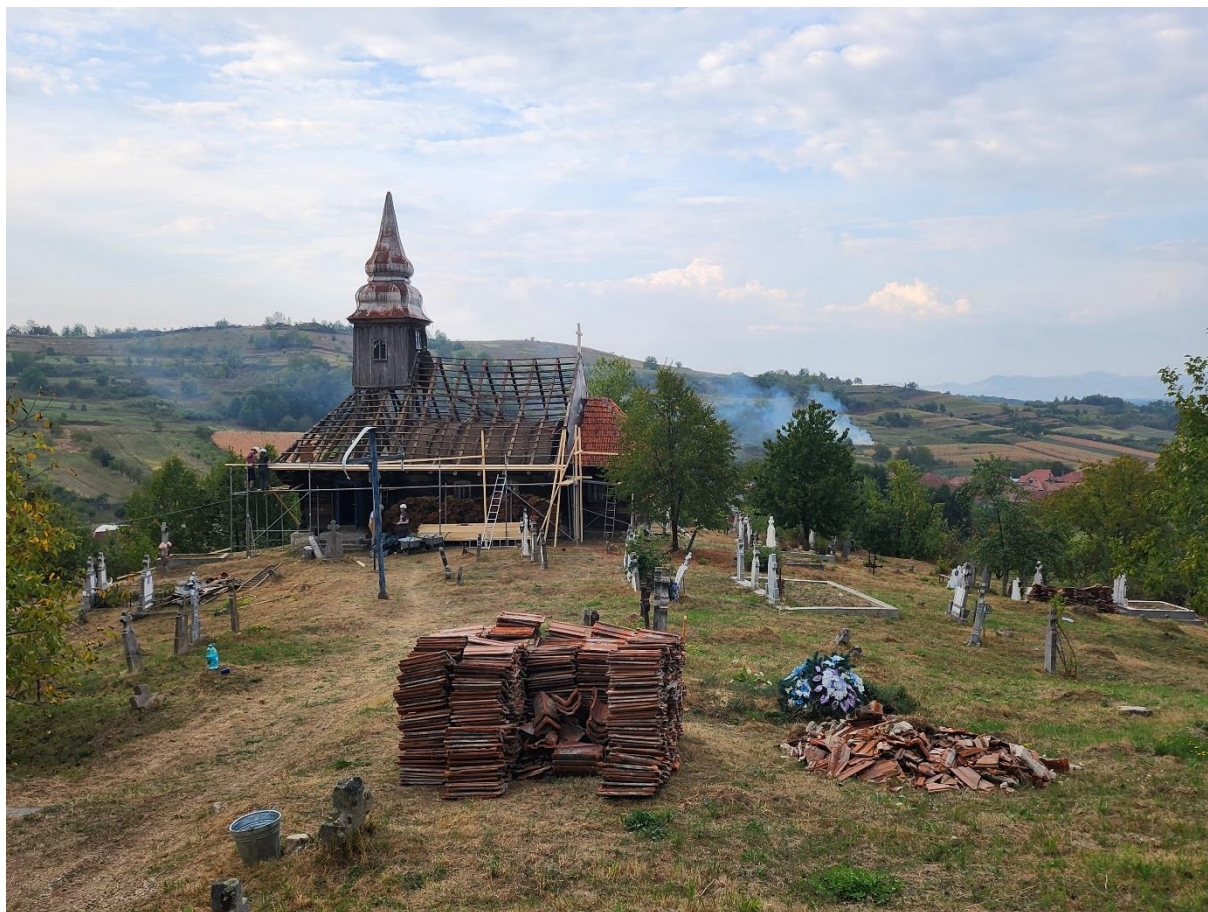
Figura 3. Momentul de tranziție: îndepărtarea țiglei și pregătirea pentru șindrilă
