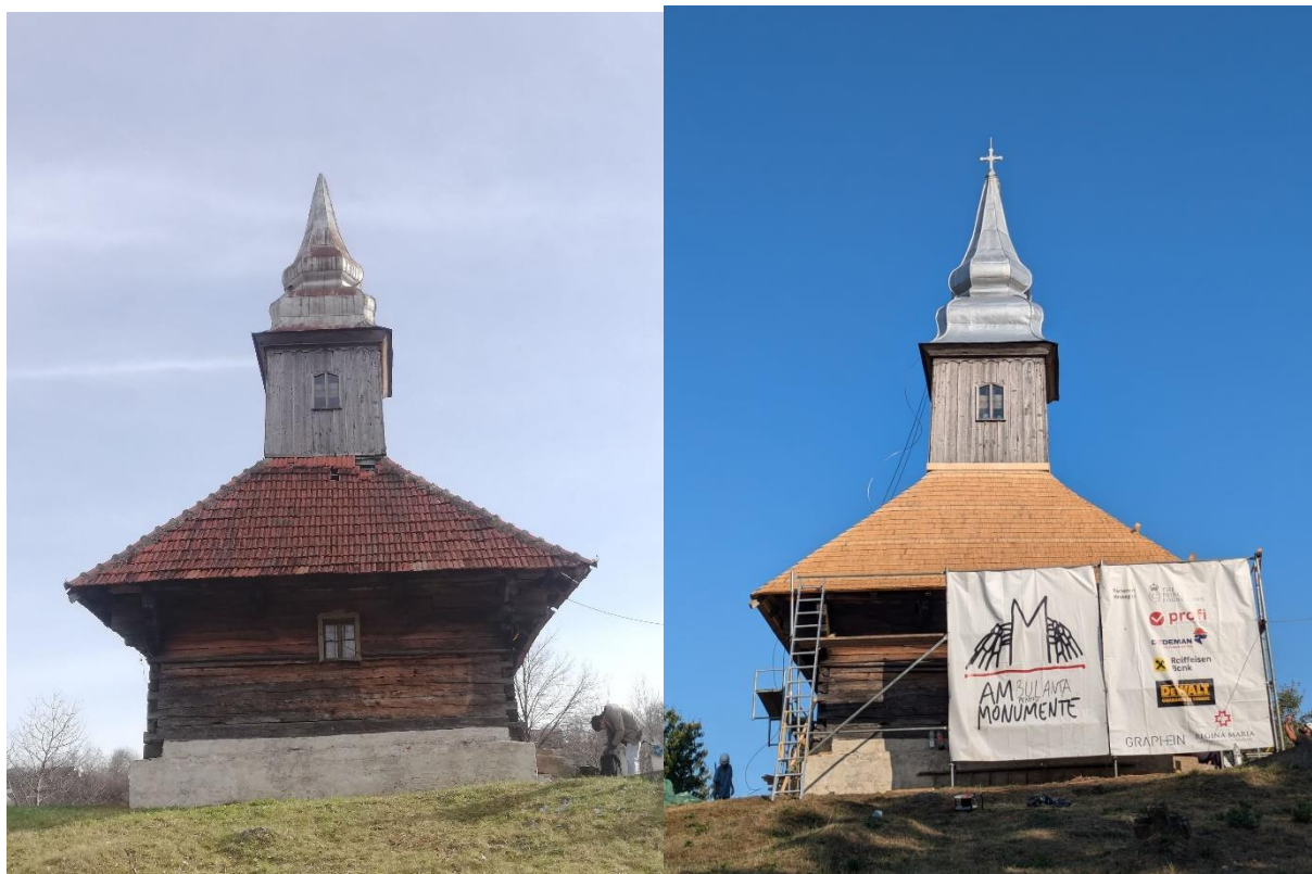
Figura 8. Transformarea bisericii: înainte și după intervenție
