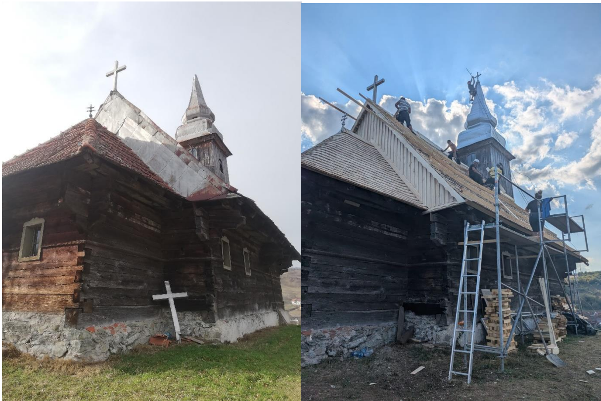
Figura 6. Transformarea bisericii: de la învelitoarea degradată la montarea noii șindrile.
